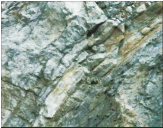
图 1 某露天矿边坡节理裂隙发育区域
