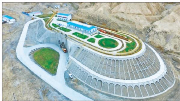
图 2 利用井下废渣建成的采运矿调度中心
