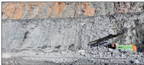
c) 西源岭和黄坑交界处边坡215 m台阶坡面
