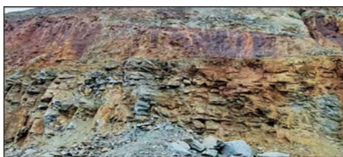
a) 老卡调楼边坡80 m台阶坡面
