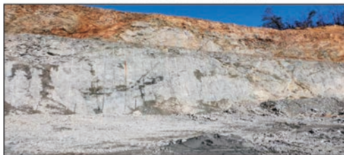
b) 黄坑边坡215 m台阶坡面
