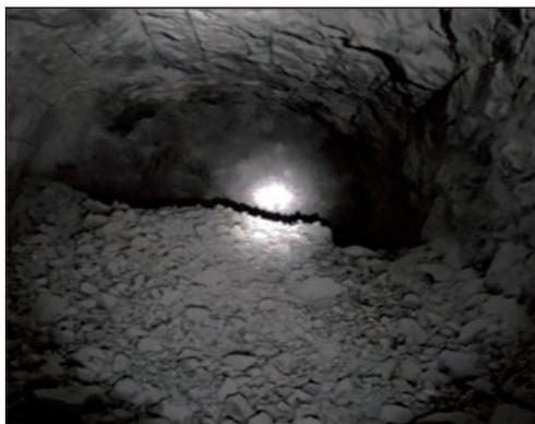
a) 一段掘进爆破整体块度
